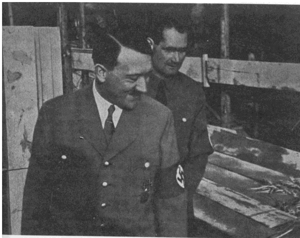
-Hitler y Hess, su Secretario Particular, visitan las obras de construcción de un monumento nacionalsocialista.
